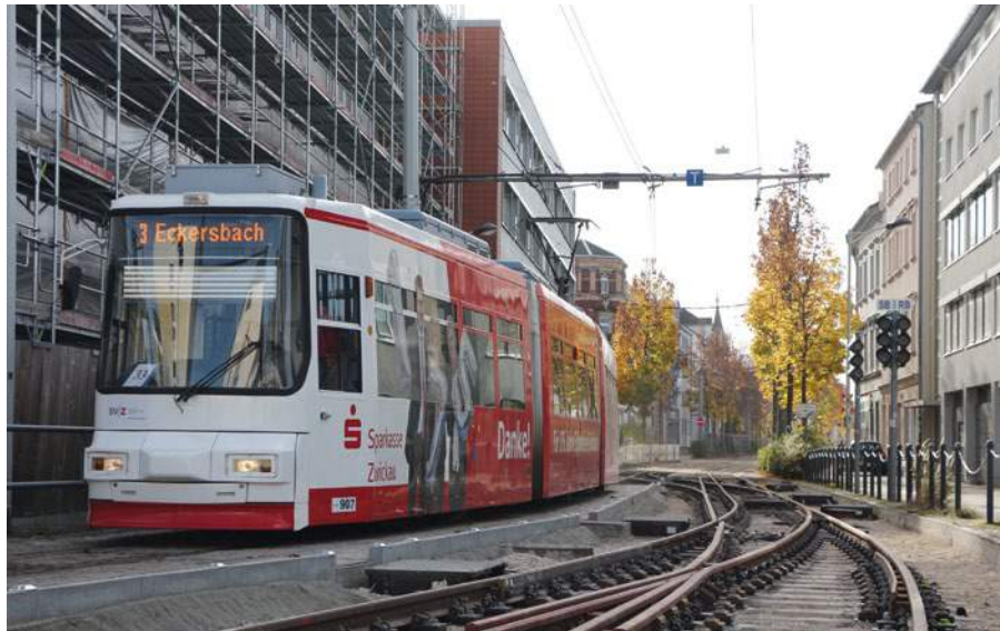
7: Wagen 907 als Linie 3 am ersten Betriebstag im Bereich der Sonderweichen Zentrum, im Vordergrund Weiche 201 - dahinter Weichen 202 und 203 (29.10.2022)
