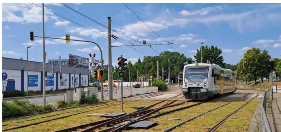
8: Länderbahn-Triebwagen 650 569 als Linie RB 1 am ersten Betriebstag im Bereich der Sonderweichen Stadthalle, im Vordergrund Kreuzung Kr 1 (08.07.2023)
