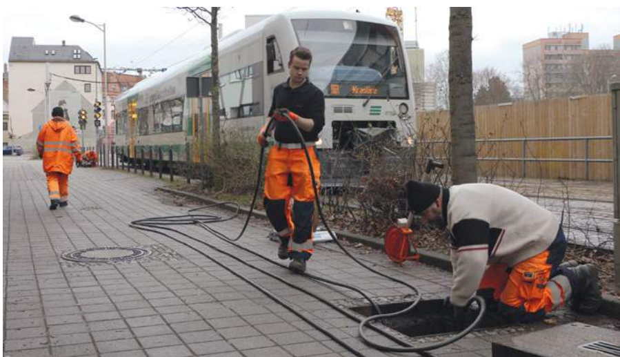
2: Kabelzug zum Anschluss der Leittechnik auf Seite Zentrum (RB 20813 nach Kraslice, 03.02.2021)
